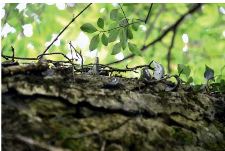
De haut en bas Fig. 63-65 • L'entrée de la cité de la Courbatière, la cité de Roussillon et un vestige du mur d'enceinte, conservant les tessons de verre visant à protéger le clos industriel et l'usine-pensionnat des intrusions. Département de l'Ain, cliché : Carine Monfray (2013)
