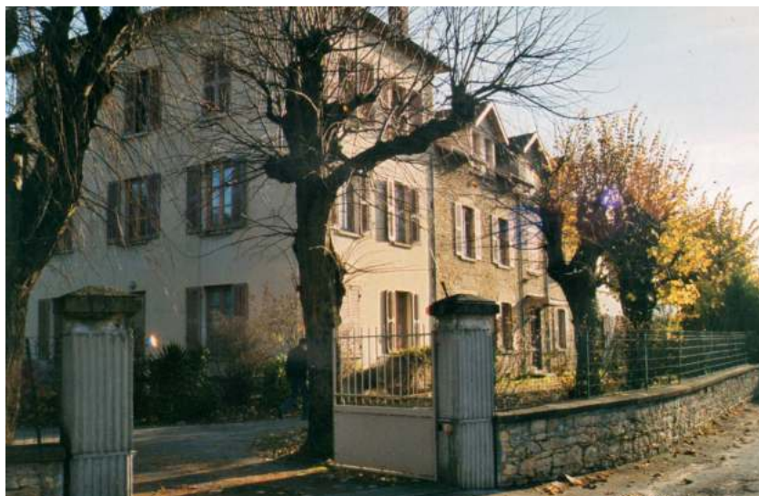
Fig. 136 • Maison Saint-Antoine de la cité ouvrière de Bousieu devenue aujourd'hui une copropriété.
