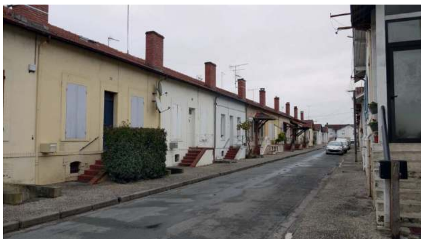
Fig. 123 • Maison, rue Torikian, commune de Fumel. Le logement ne comprend qu'un seul niveau. Les façades alignées sont toutes identiques : deux ouvertures encadrent la porte d'entrée.
