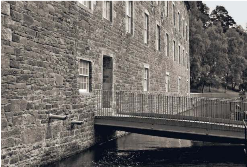
Fig. 141 • Ancienne usine n° 3 et canal. Le canal, relié au fleuve Clyde, servait à actionner les métiers à filer hydrauliques de New Lanark, et constituait une réserve d'eau potable pour les habitants du village. L'usine n° 3 accueille aujourd'hui un musée recevant près de 300 000 visiteurs par an.
