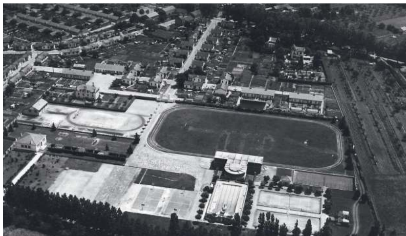
Fig. 126 • Stade Henri-Cavailler, commune de Fumel, en 1955. De gauche à droite, on distingue les maisons alignées le long de la rue Torikian, le gymnase, une piste d'athlétisme et le stade de rugby. Fonds privé
