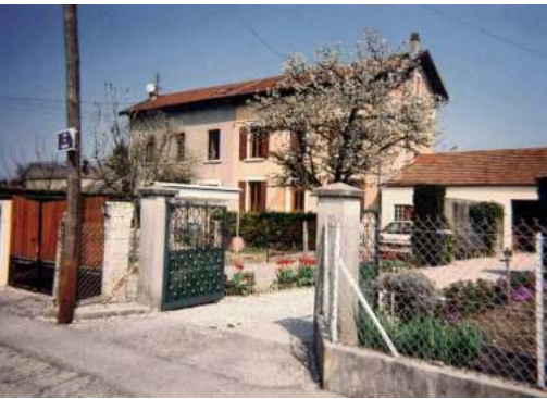
Fig. 135 • Modernisation et aménagement des anciens bâtiments de la cité ouvrière de Boussieu, à partir des années 1970-1980.
