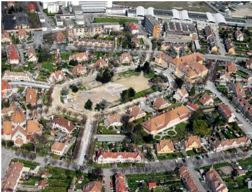
Fig. 12 • Vue aérienne de la cité de Chemin Vert. À côté de la Maison Commune, la Maison de l'Enfance était complètement dédiée à la femme et à l'enfant. Cliché : O. Rigaud
