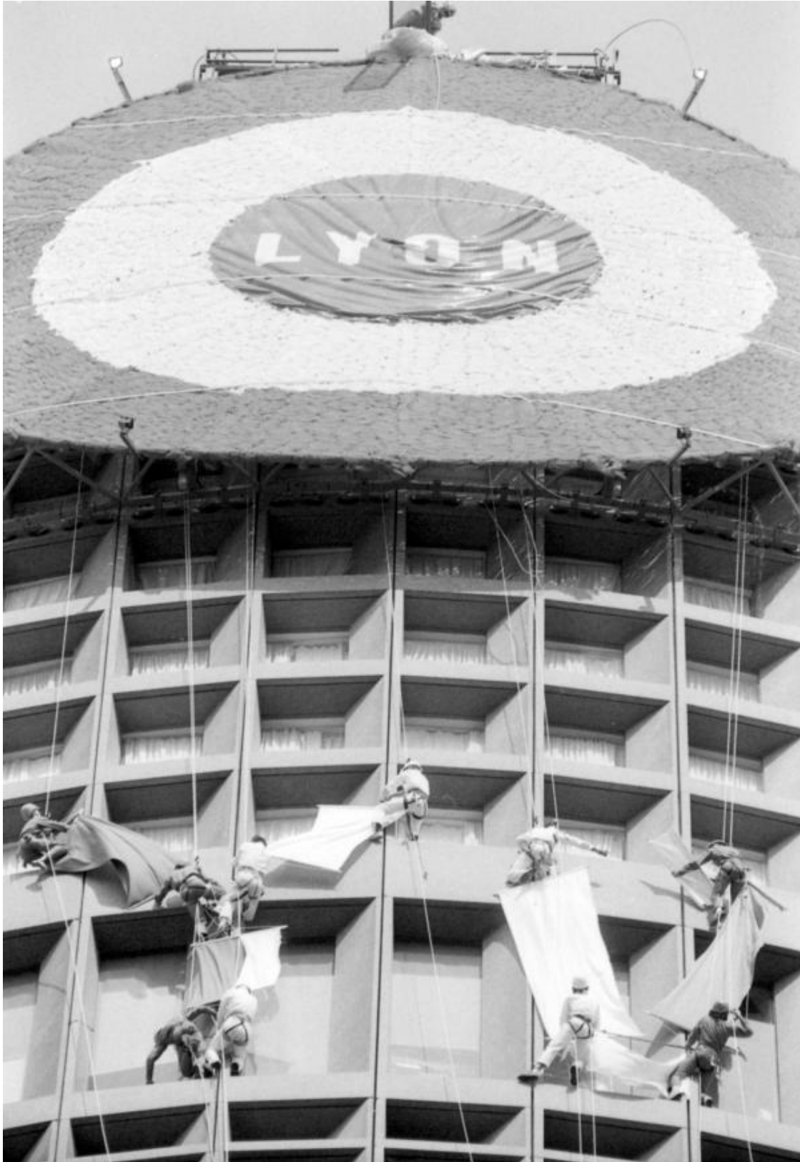
Document V-3 – Démontage de la cocarde du Bicentenaire réalisée par EMC
