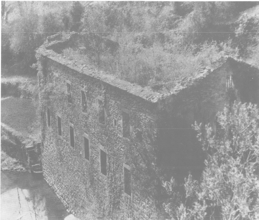
Ci-dessus : Types architecturaux. Ci-dessous : Moulinage ruiné à Privas, Ardèche. Les ouvrages de charpenterie effondrés laissent voir l'espace de la salle-haute (étage d'habitation) gagnée par la végétation. L'essentiel des structures maçonnées subsistent, y compris les fermatures d'avant-toit.
